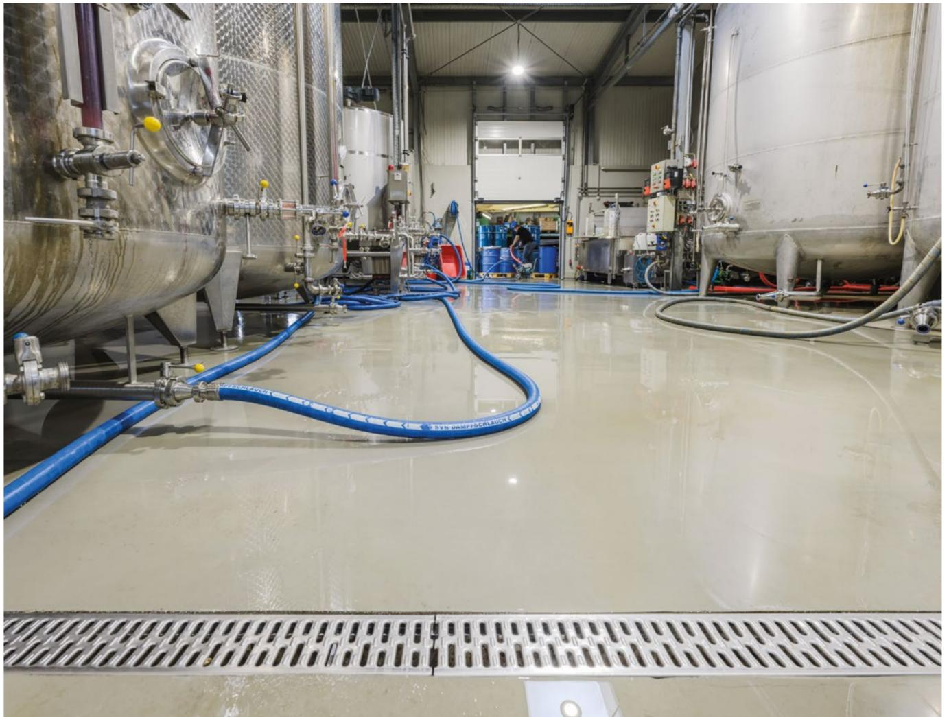
Dank der neuen PU-Betonbeschichtung ist der Boden der Produktionsstätte für jede Belastung des Arbeitsalltags gerüstet.
