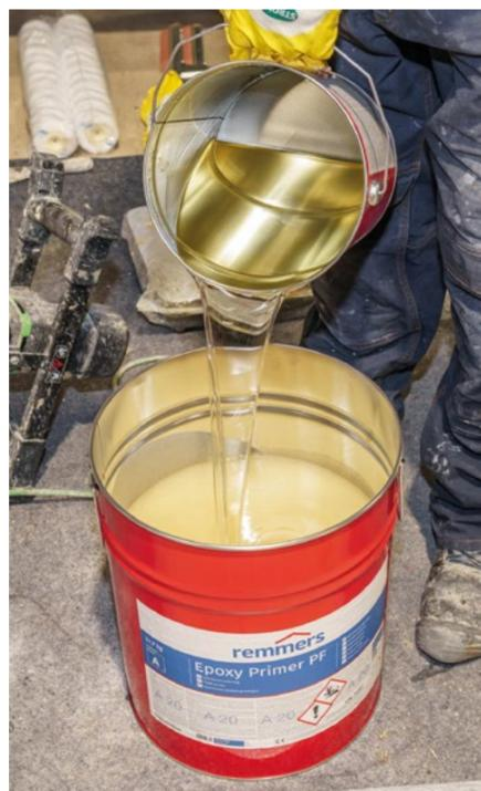
Der Epoxy Primer PF bildet die Grundlage für den neuen Boden der Flaschenreinigung.
