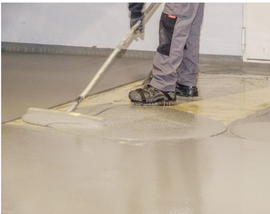
Nach Auftragen des Crete-Fließbelags zeigt sich der Untergrund selbst bei hohen Gewicht- und Temperatureinwirkungen widerstandsfähig.
